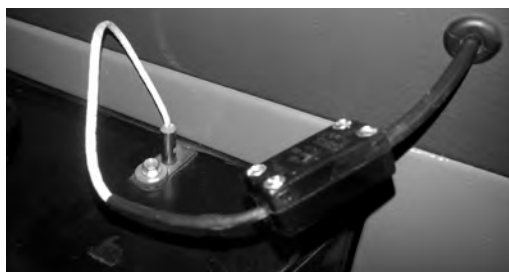
Rysunek 2 Czujnik temperatury spalin zamontowany w czopuchu
