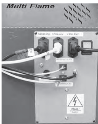
Rysunek 3 Moduł sterujący pracą palnika. (uwaga fot. przedstawia przykładowy wygląd listwy w zależności od modelu sterownika zamontowanego na kotłach)
