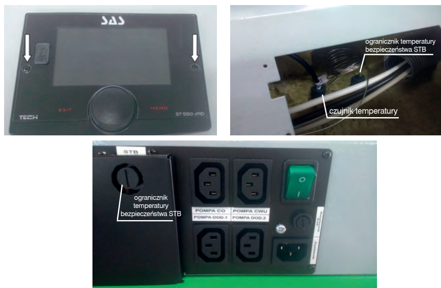
Rysunek 13 Lokalizacja ogranicznika temperatury bezpieczeństwa STB oraz czujnika temperatury
