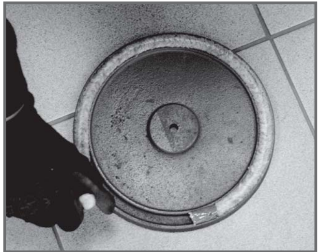
Fot. 2. Wymiana sznura uszczelniającego.
