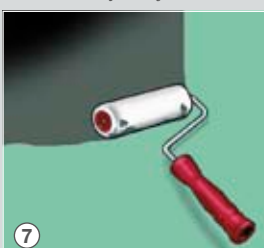
7 Powierzchnię pokryć preparatem uszczelniającym.
