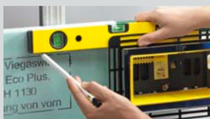
1 Przenieś kształt ramki montażowej na płycie do zabudowy i wytnij otwór piłą otwornicą.
