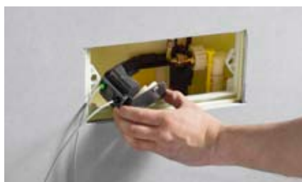
1 W miejsce zestawu dźwigni zamontuj ciągnio Bowdena z silnikiem nastawczym.
