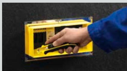
3 Zamocuj płytkę ceramiczną lub indywidualnie wybrany element okładziny ściennej. Wyreguluj położenie ramki montażowej w jednej płaszczyźnie ze ścianą.
