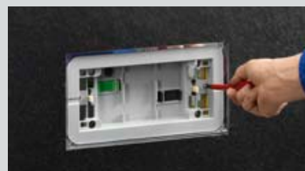
4 Umocnij płytkę podstawową na spłuczce, a następnie załóż płytkę uruchamiającą.
