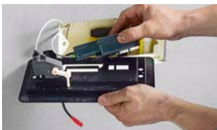
2 Obudowę z silnikiem nastawczym załóż na ramę montażową; dodatkowo zamontuj mechaniczny wyzwalacz spłukiwania w sytuacjach awaryjnych.
