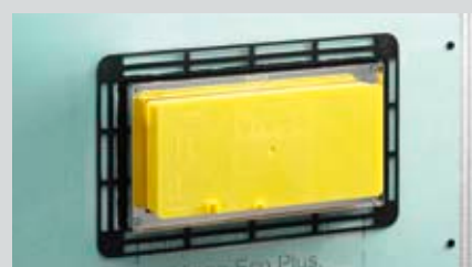
2 Ustaw odpowiednio ramkę montażową na płycie kartonowo-gipsowej, po czym przyklej do płyty.
